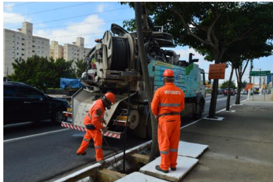
Legenda: Exemplo de Serviço de Microdrenagem.
